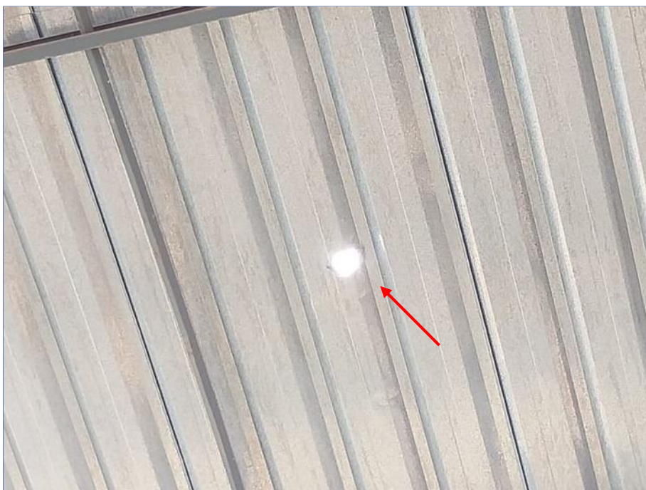
FOTO Nº 169: Telha metálica danificada.
