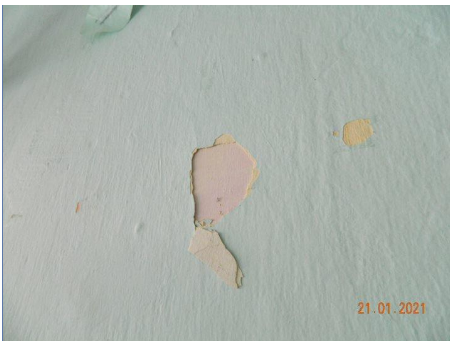
FOTO Nº 089: Sinal de descascamento de pintura.
