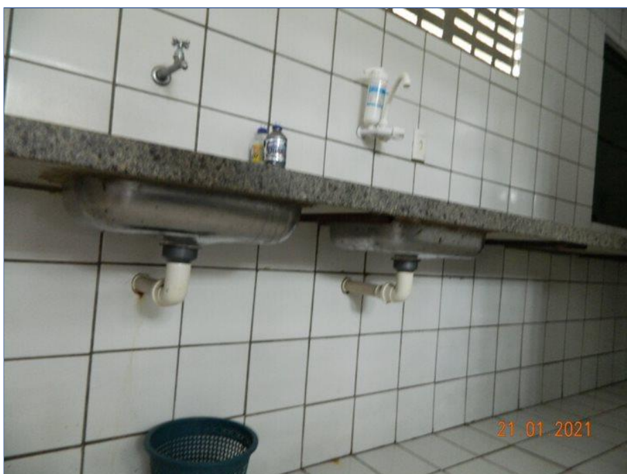
FOTO Nº 142: Instalação hidrossanitária irregular.
