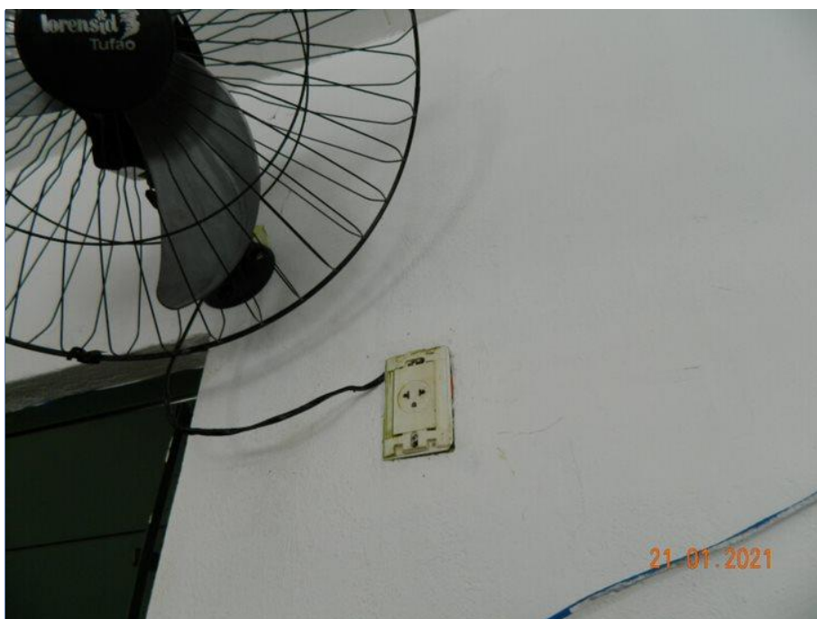
FOTO Nº 042: Instalação elétrica irregular.
