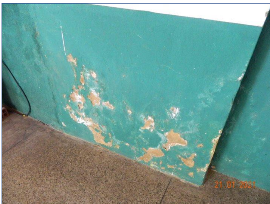
FOTO Nº 064: Sinal de descascamento da pintura.
