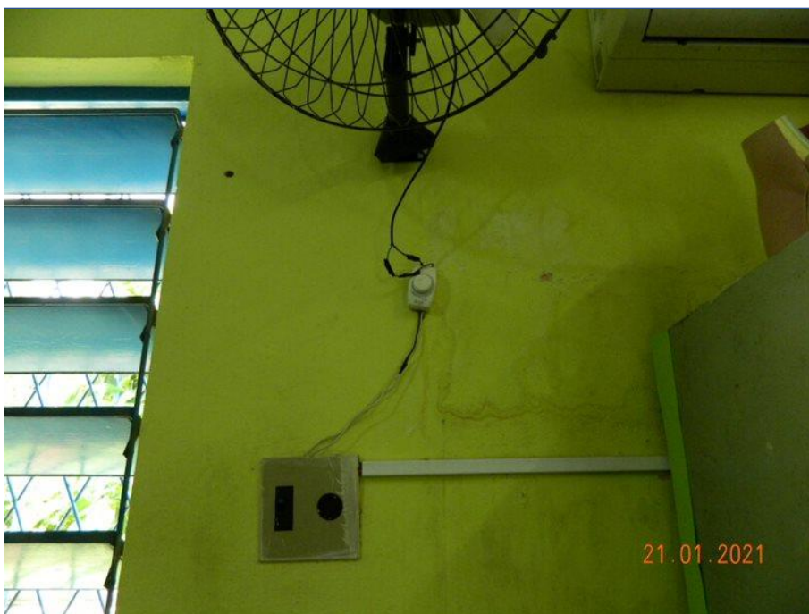
FOTO Nº 076: Instalação elétrica irregular.
