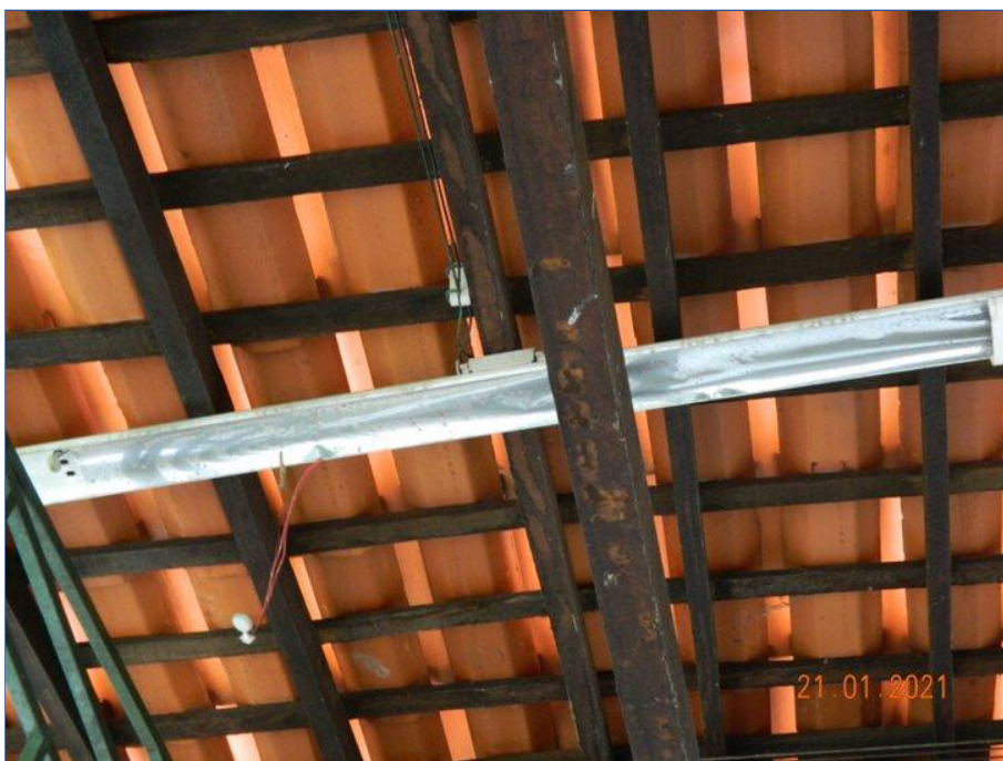
FOTO Nº 062: Instalação elétrica irregular.
