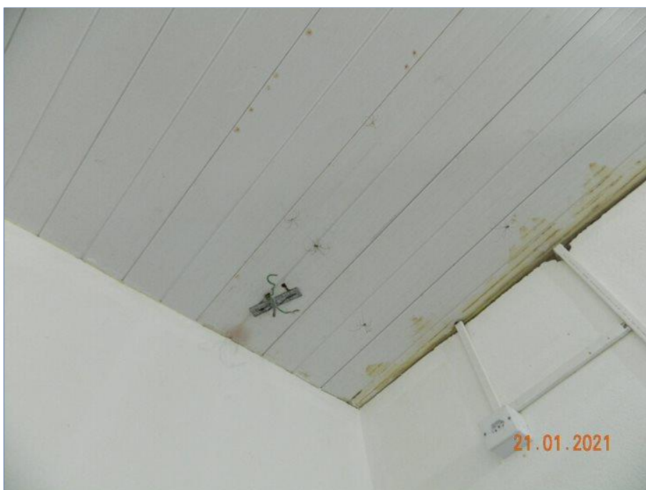
FOTO Nº 029: Forro danificado e instalação elétrica irregular.
