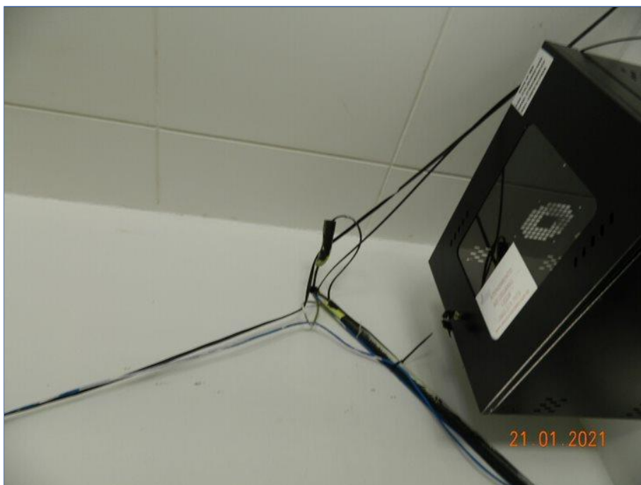
FOTO Nº 040: Instalação de lógica irregular.
