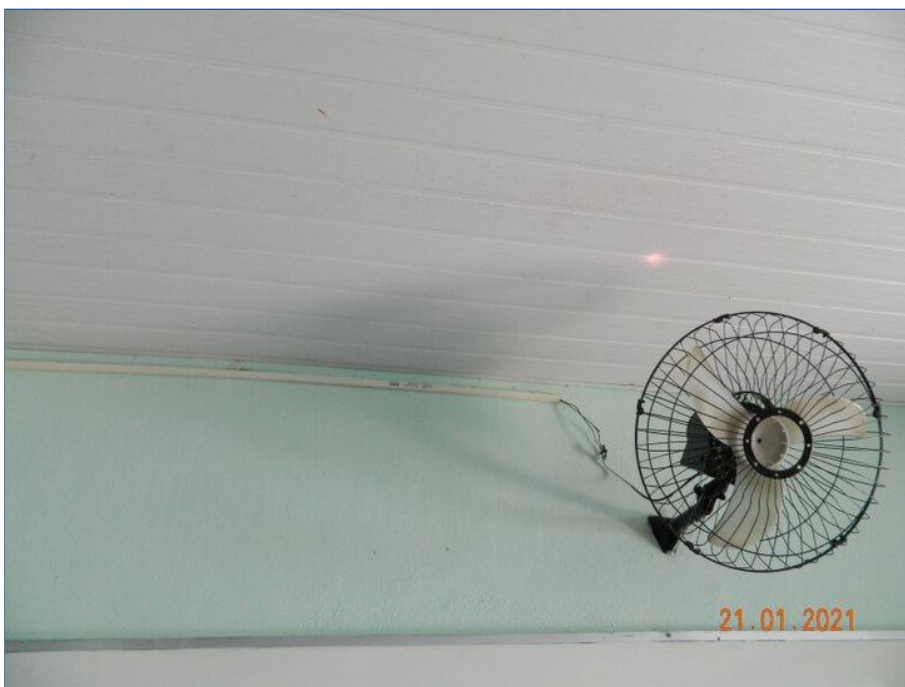
FOTO Nº 086: Instalação elétrica irregular.
