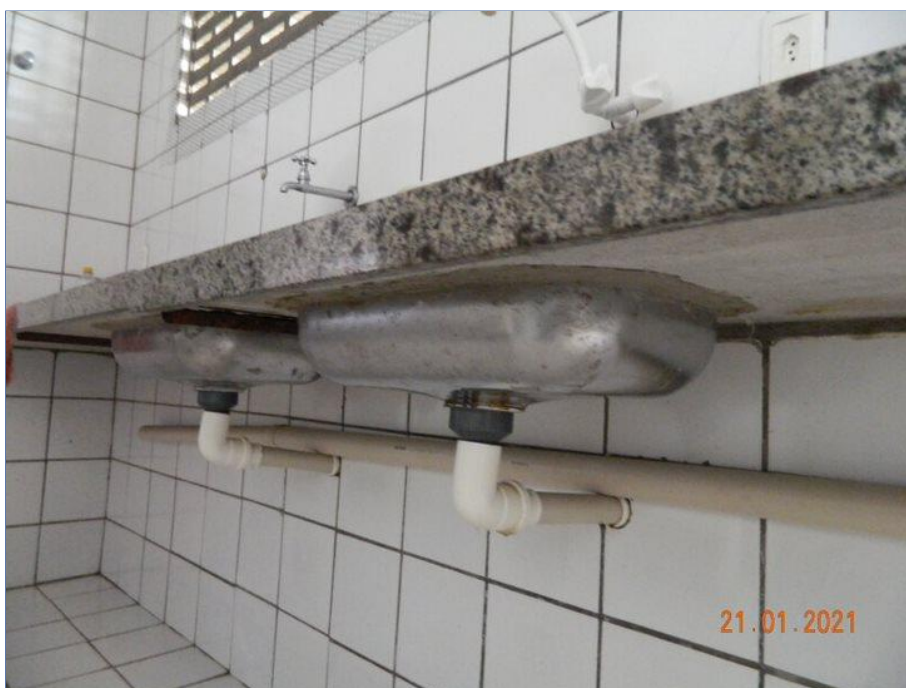
FOTO Nº 139: Instalação hidrossanitária irregular.
