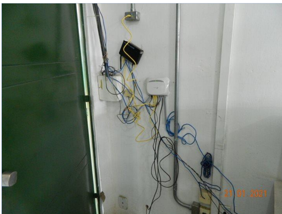
FOTO Nº 047: Instalação de lógica irregular.
