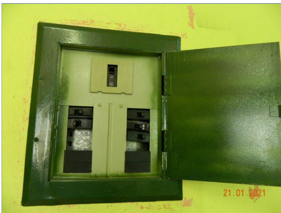
FOTO Nº 072: Quadro elétrico sem identificação.
