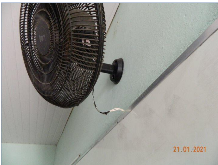
FOTO N° 120: Instalação elétrica danificada.
