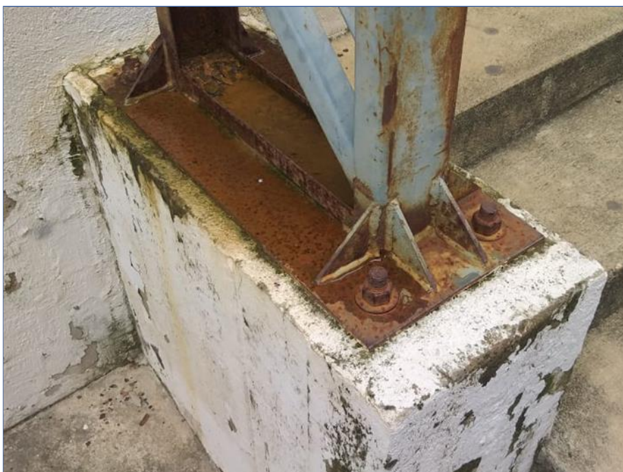
FOTO Nº 166: Estrutura metálica com sinal de corrosão e acúmulo de água.
