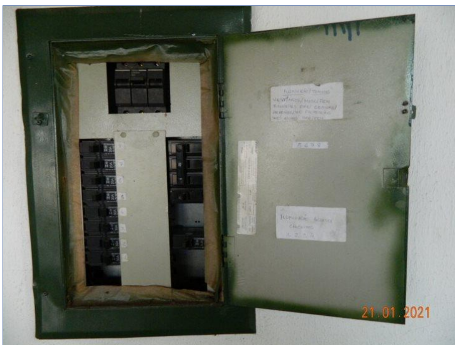
FOTO Nº 058: Quadro elétrico parcialmente identificado.
