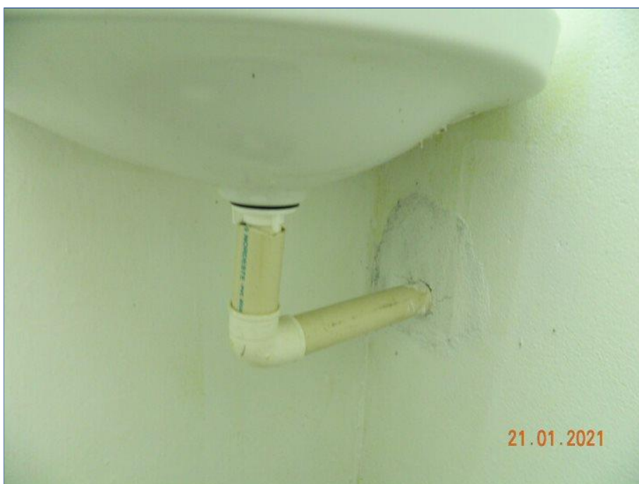
FOTO Nº 034: Instalação hidrossanitária irregular.
