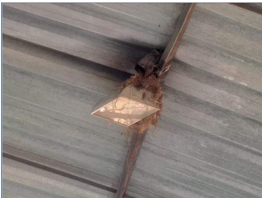
FOTO Nº 168: Ninho de ave sobre a instalação elétrica.
