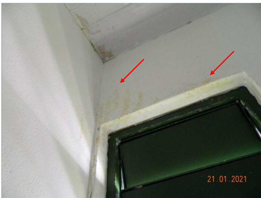
FOTO Nº 035: Sinal de descascamento de pintura.
