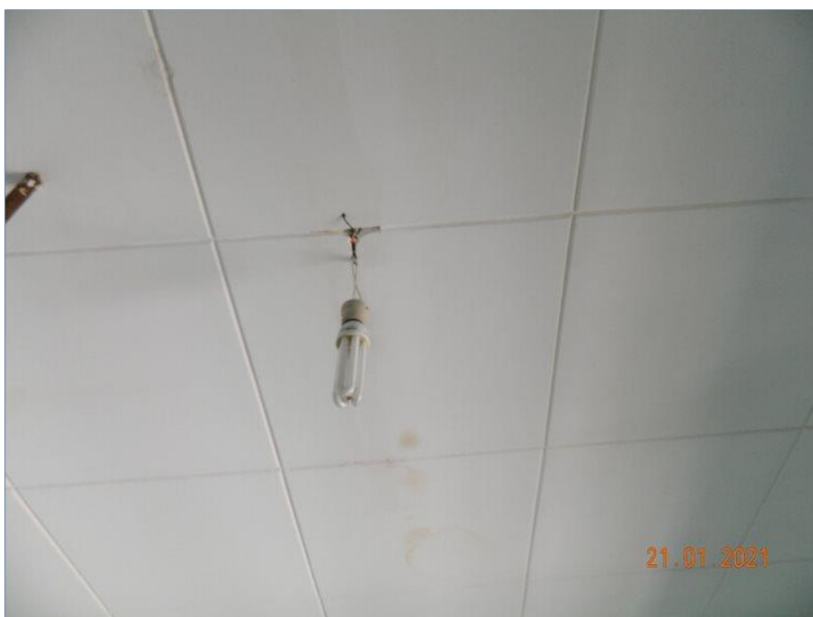
FOTO Nº 043: Instalação elétrica irregular.
