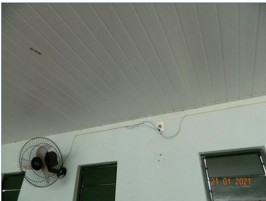
FOTO Nº 116: Instalação elétrica irregular.
