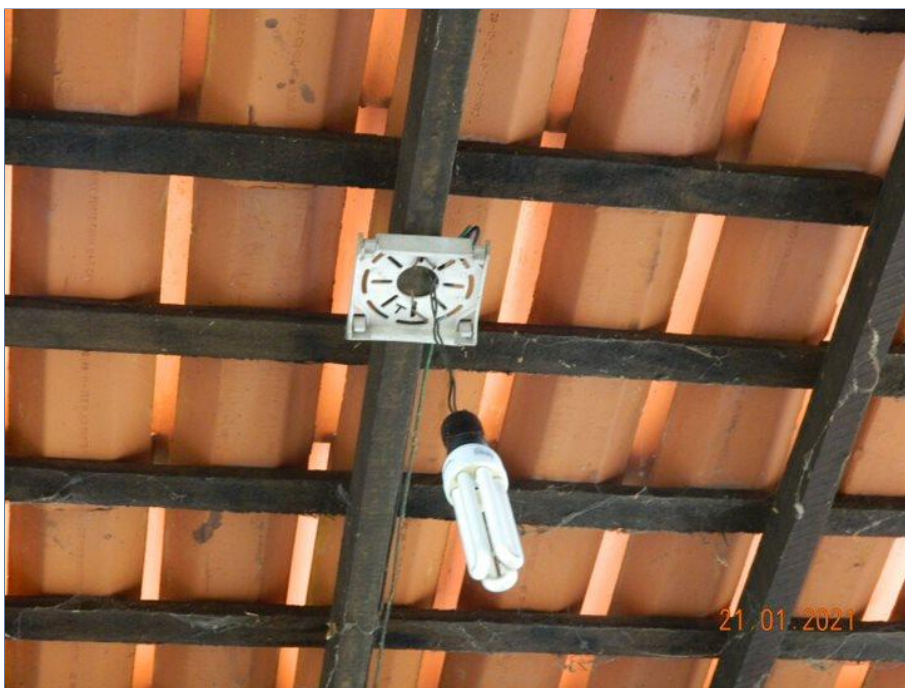
FOTO Nº 061: Instalação elétrica irregular.
