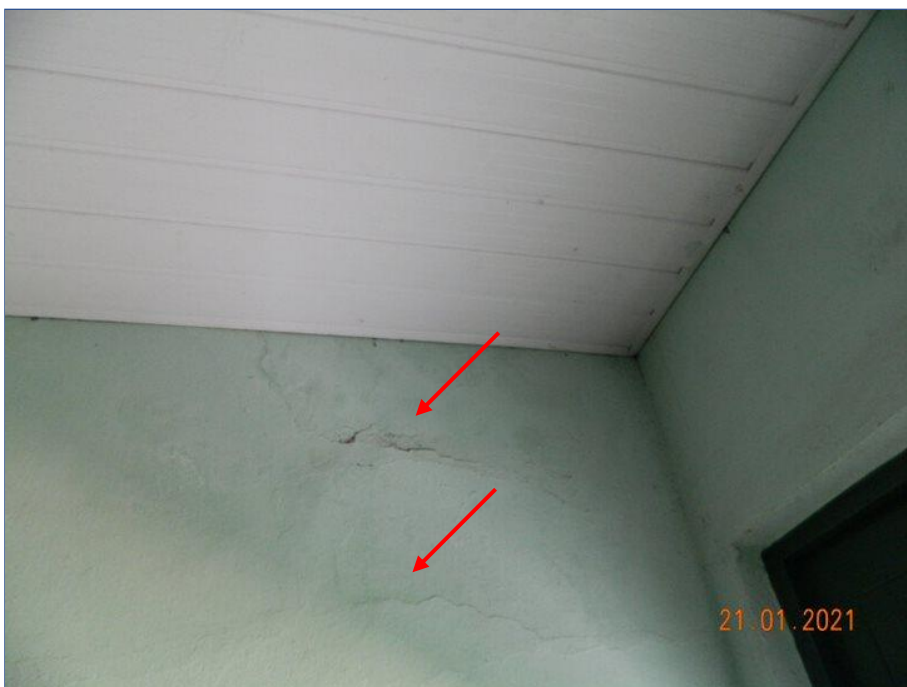
FOTO N° 112: Trinca na parede.
