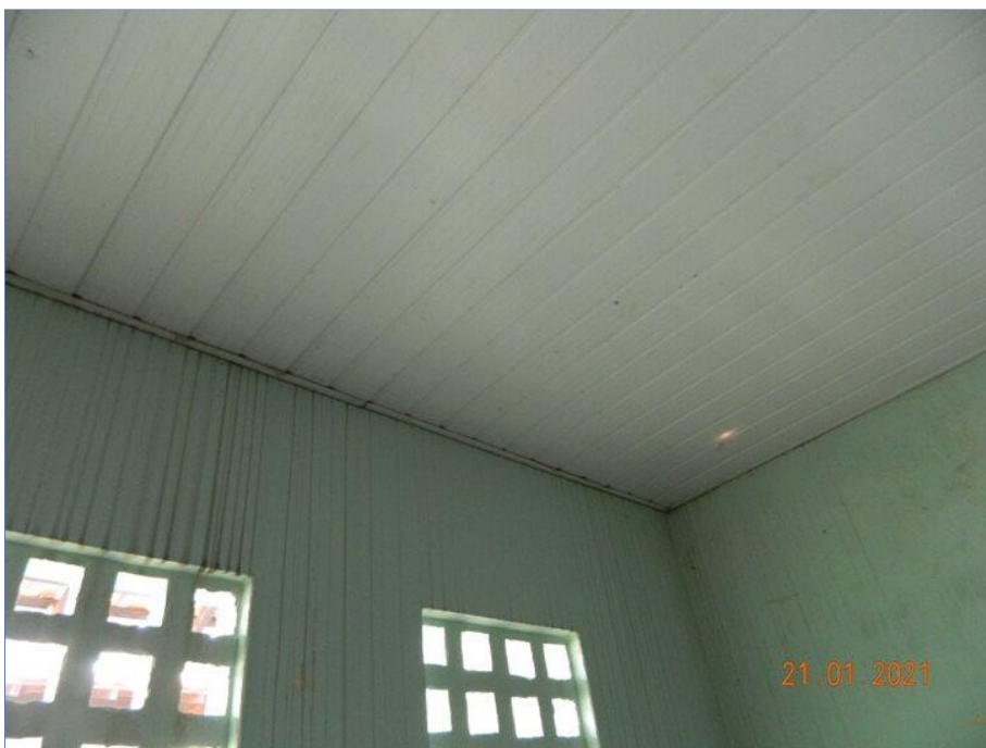
FOTO Nº 115: Sinal de infiltração.
