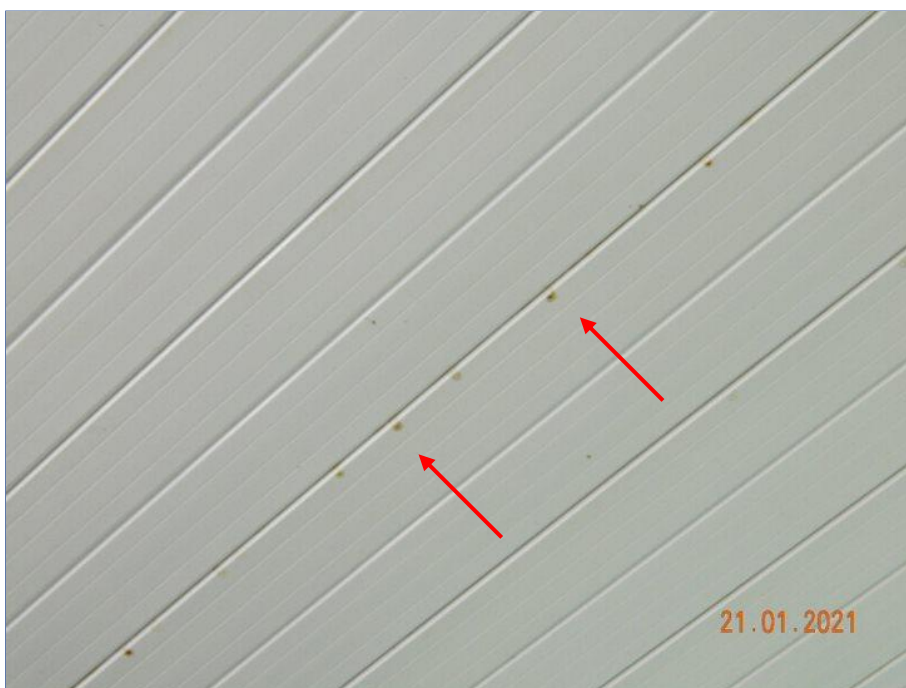
FOTO Nº 015: Sinal de infiltração.
