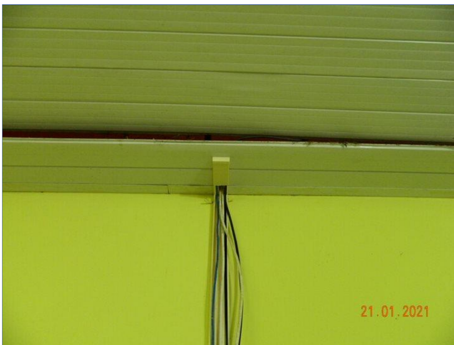
FOTO Nº 078: Instalação de lógica irregular.
