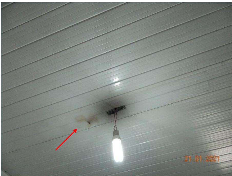
FOTO Nº 017: Forro danificado e instalação elétrica irregular.
