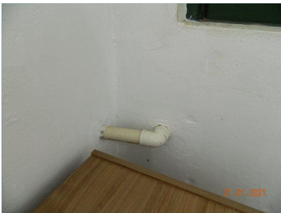
FOTO Nº 027: Instalação hidrossanitária irregular.
