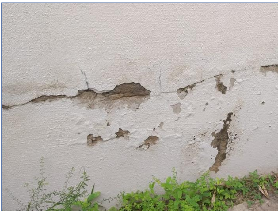
FOTO Nº 167: Rachadura na base da platibanda.
