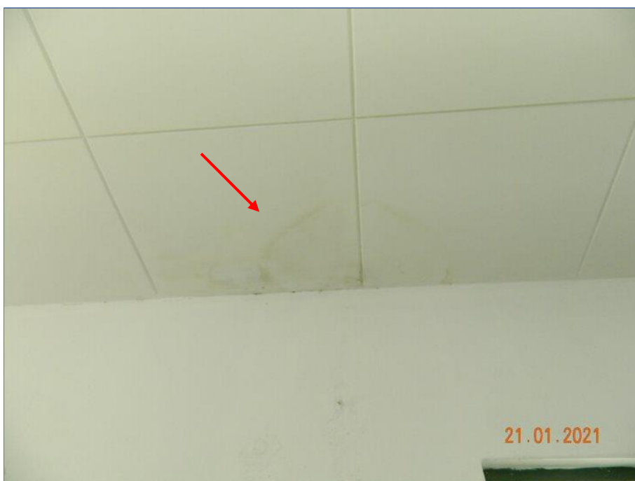
FOTO Nº 046: Sinal de infiltração.
