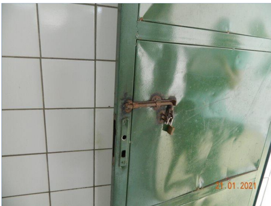
FOTO Nº 127: Porta metálica danificada.
