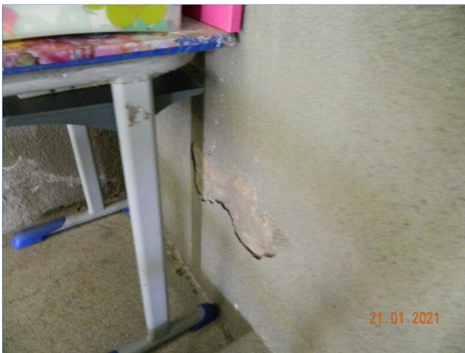
FOTO Nº 093: Sinal de descascamento da textura.
