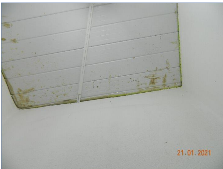
FOTO Nº 033: Forro danificado e instalação elétrica irregular.
