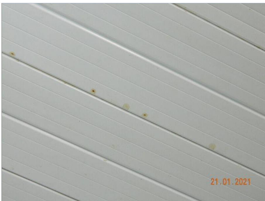
FOTO Nº 031: Sinal de infiltração.
