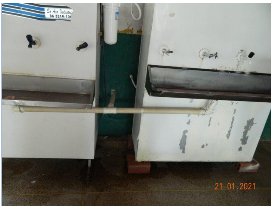
FOTO Nº 065: Instalação hidrossanitária irregular.
