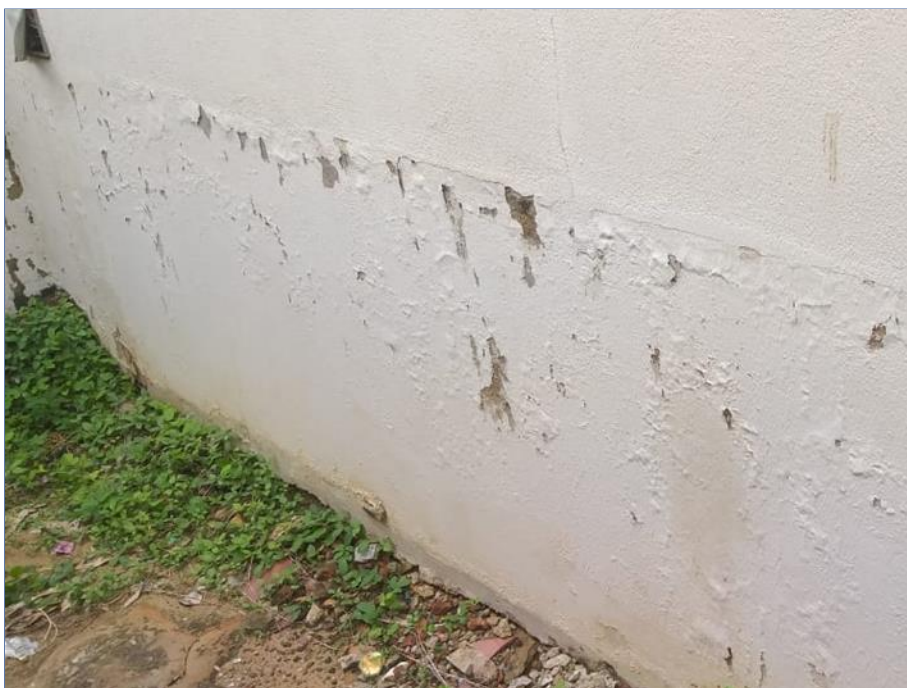
FOTO Nº 165: Sinal de descascamento de pintura.
