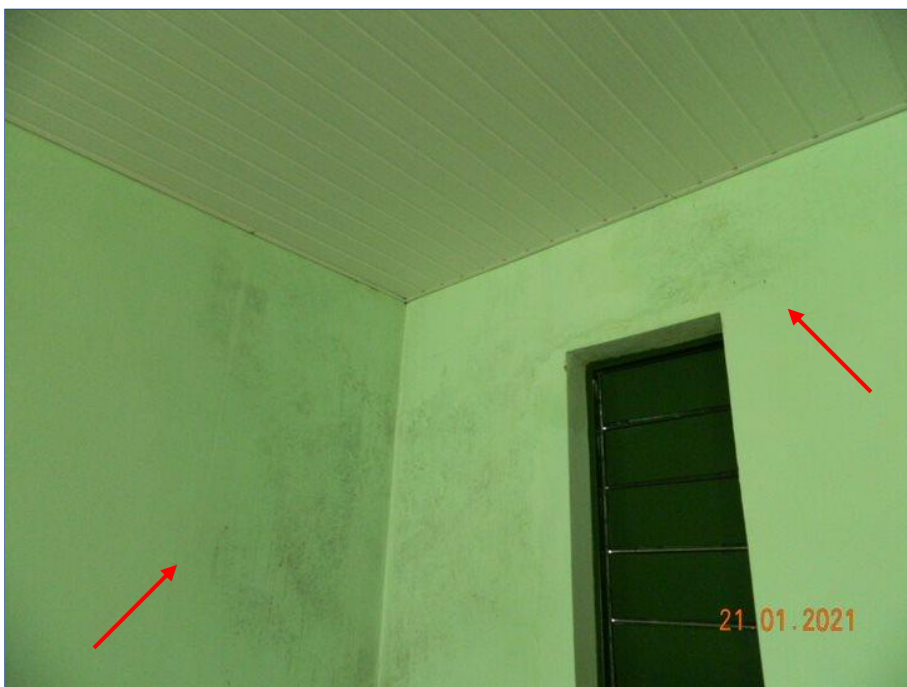
FOTO Nº 106: Sinal de infiltração.
