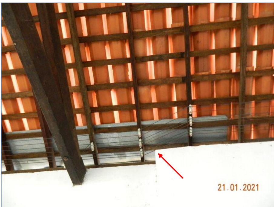
FOTO N° 060: Instalação elétrica irregular.
