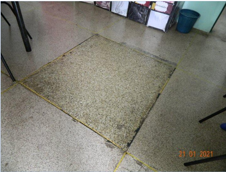
FOTO Nº 021: Assentamento irregular do piso granilítico.
