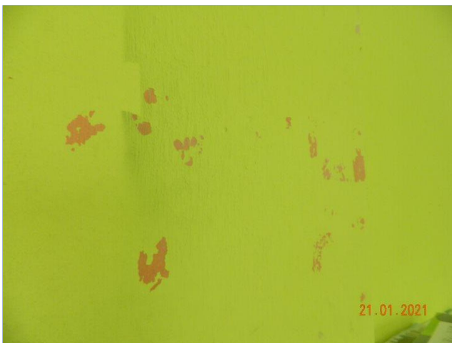
FOTO Nº 073: Sinal de descascamento de pintura.
