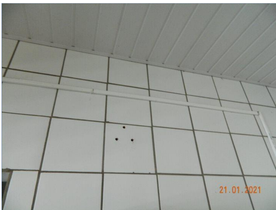
FOTO Nº 143: Revestimento cerâmico danificado.
